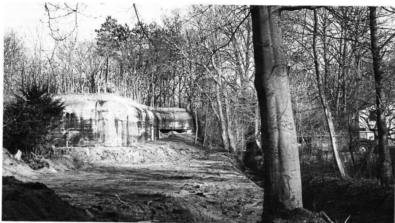
Het herenhuis Schoonenberg (rechts) met een van de Duitse commandobunkers (typen. 117a. In afwijking van gelijke bunkers elders was deze bunker voorzien van een dak met een dikte van 3 meter bewapend beton en een zogenaamd Westwall-schietgat, op de foto duidelijk zichtbaar. Foto februari 1995.
