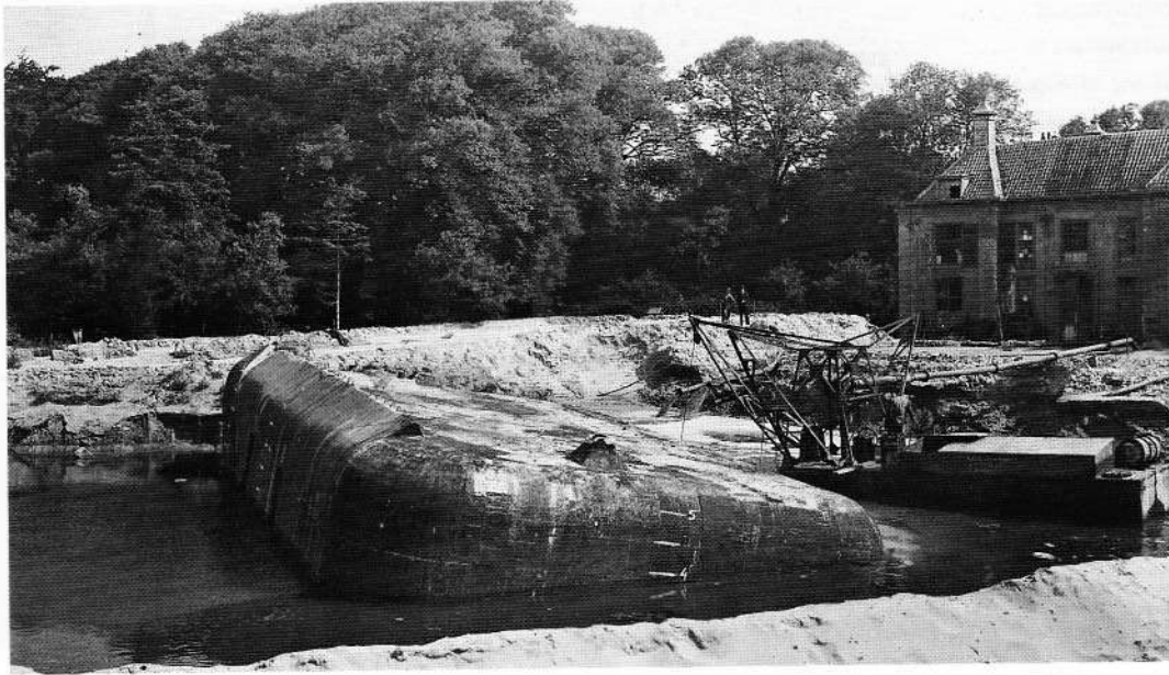
Het laten afzinken van de manschappenbunker direct achter het herenhuis Beeckestijn, zomer 1947.
