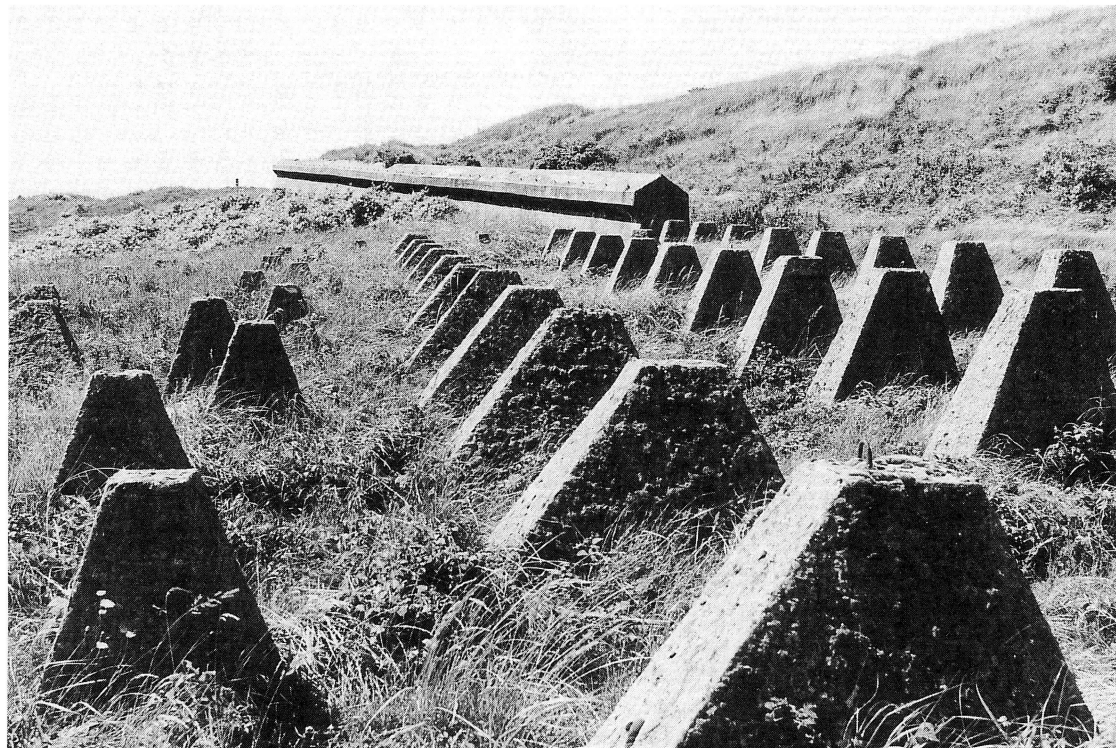
Zware muren van gewapend beton en drakentanden in de Heerenduinen als onderdeel van de verdediging van de Festung IJmuiden . Foto 1988.
