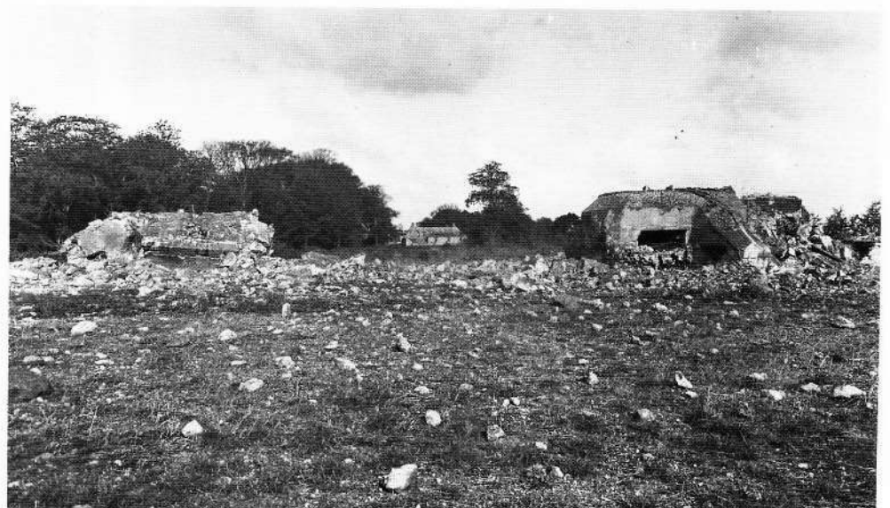
Afbraak door middel van explosieven van de geschutsbunker op de Krommelanden. Op de achtergrond de zuidkant van het herenhuis Beeckestijn en het zuidelijk koetshuis, 1946.
