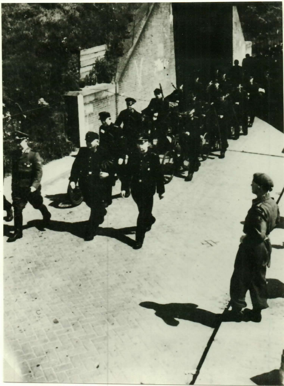
Stationsweg, Spoorwegviaduct. mei 1945
